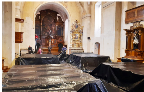
Kostel pod igelítem, čeká na lešení.
